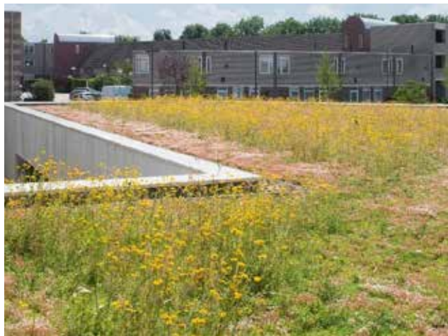
Referentiebeeld extensieve daken
